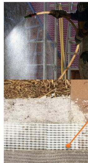
Erste Putzschicht ca. 2-2,5 cm dick ausführen und das Panzergewebe oben einbetten
