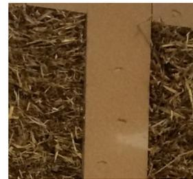
3. **Sauberkeitsschicht** gräfix 73 Pajalith in das Stroh gut einarbeiten und bis auf Oberkante der Holzkonstruktion inkl. Putzträger aufputzen und plan abziehen – Empfehlung mit Holzkartätsche ausführen. Oberfläche nicht verdichten, gut aufräumen und Sinterschicht entfernen.
